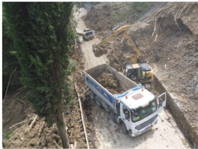
Alcuni lavori eseguiti dalla cooperativa Montana Valle del Lamone
